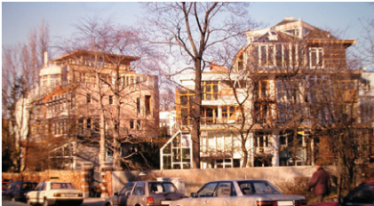
Öko-Haus Corneliusstrasse Picture credit: solidar-architekten.de/ Dr. Ludwig
